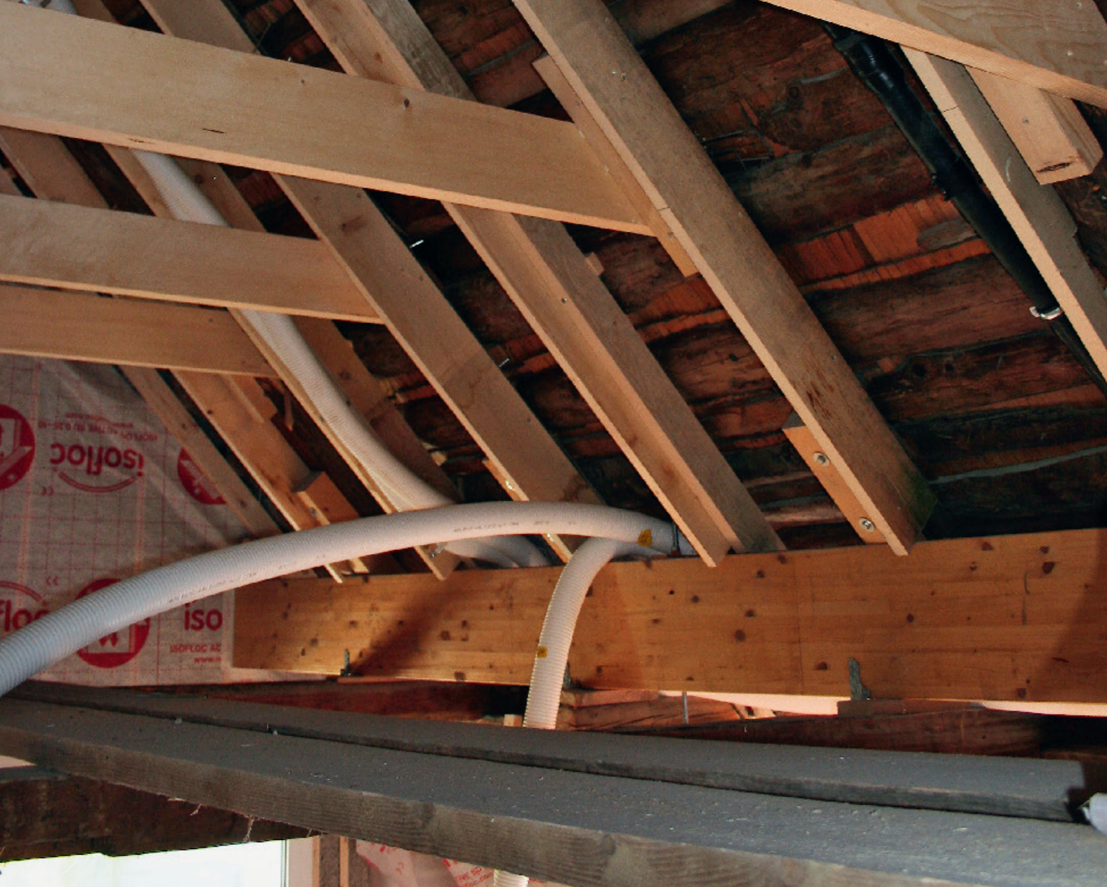
Unterschiedliche Sparrendimensionen und -sprünge – verwindetes Holz erhält seitliche Schiftung für Erhöhung Dämmquerschnitt und Nivellierung. isofloc garantiert eine fugenlose und kompakte Dämmschicht.
