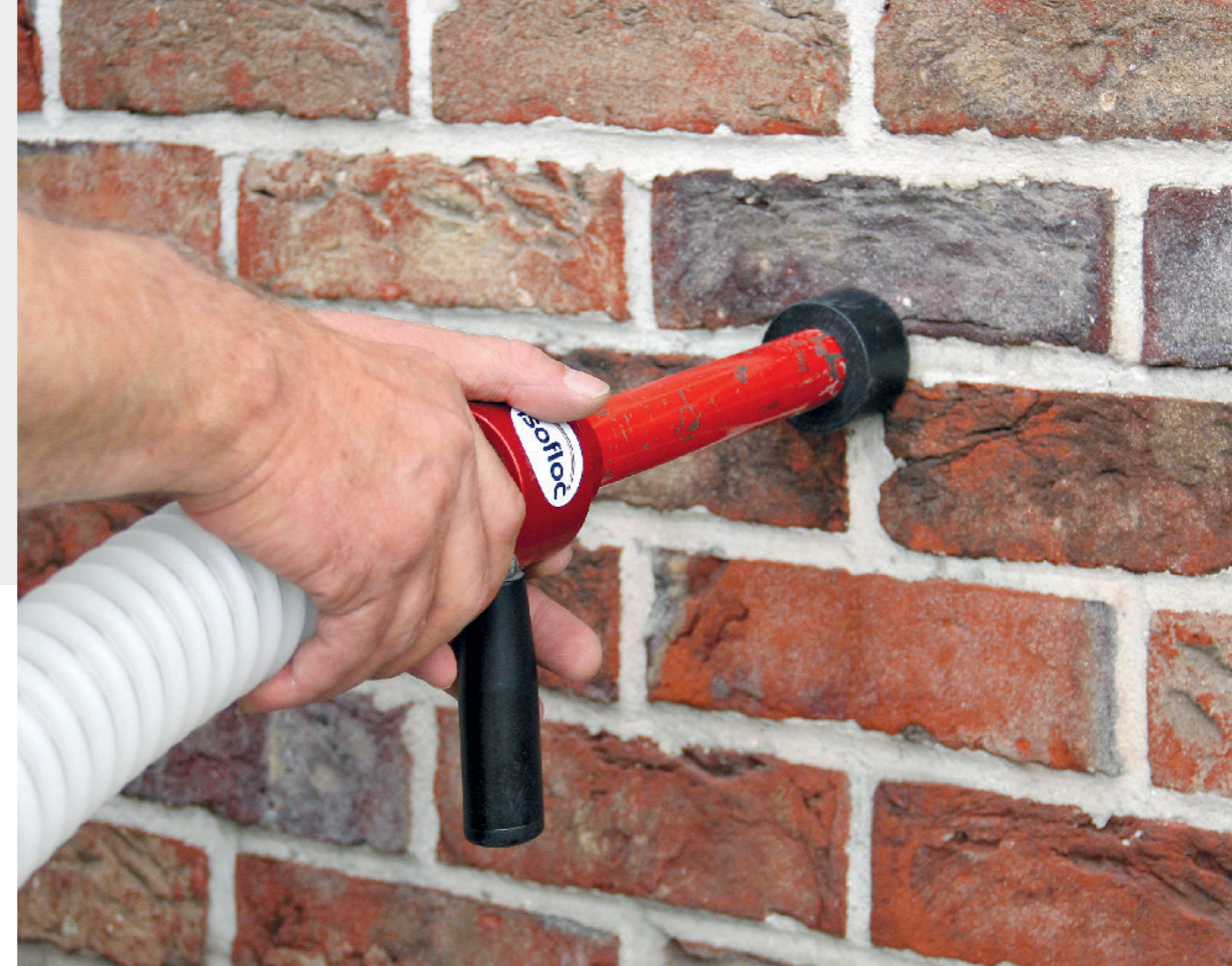
Für das nachträgliche Dämmen mit isofloc pearl müssen nur wenige punktuelle Einblasöffnungen gemacht werden.
