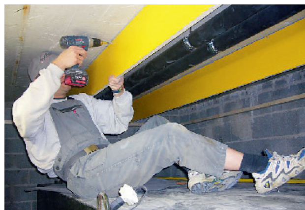
Betonkellerdecke mit Montage der Distanzstege für den mit isofloc Zellulosefasern auszublasenden Dämmhohlraum.
