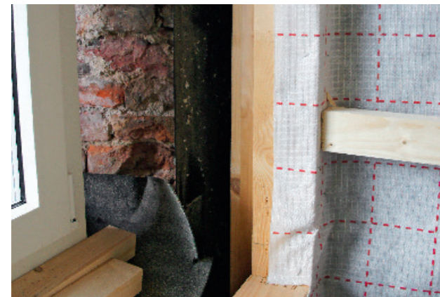
Anschlüsse der Luftdichtigkeit an andere Bauteile (hier Fenster-rahmen) sind wichtig für Bauschadenfreiheit.
