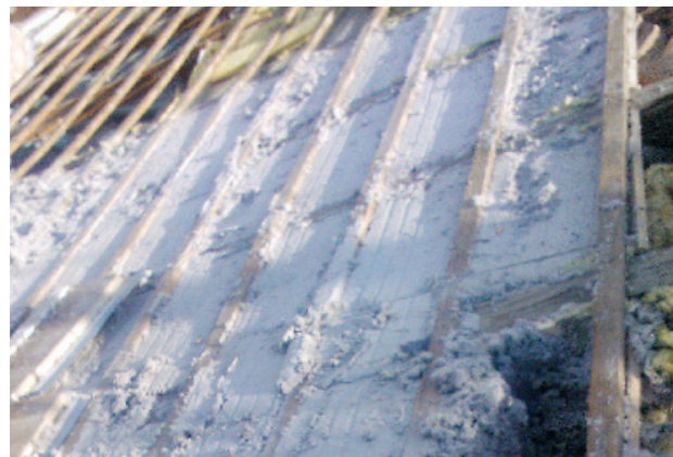
Durch Umnutzung wurde die vor Jahren aufgebaute Konstruktion zurückgebaut und anschliessend durch eine Aufsparrendämmung (siehe Seite 26-27) neu erstellt.
