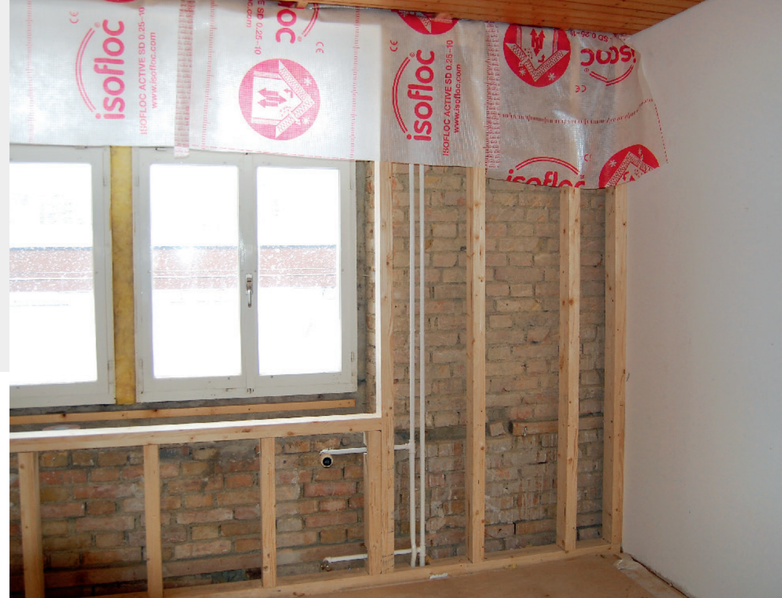
Innenansicht des Backsteinmauerwerks mit vorgesetzter Holzständerkonstruktion und feuchtevariabler Dampfbremse isofloc active sd 0.25-10.
