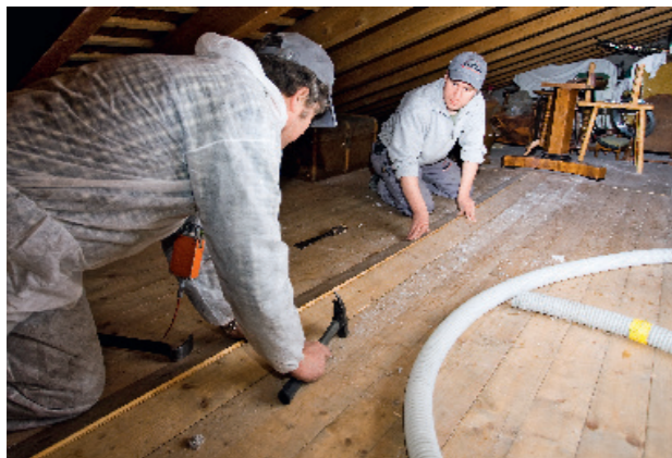
Punktuelle Entfernung der Bodenriemen, damit isofloc eingeblasen werden kann. Blindboden.
