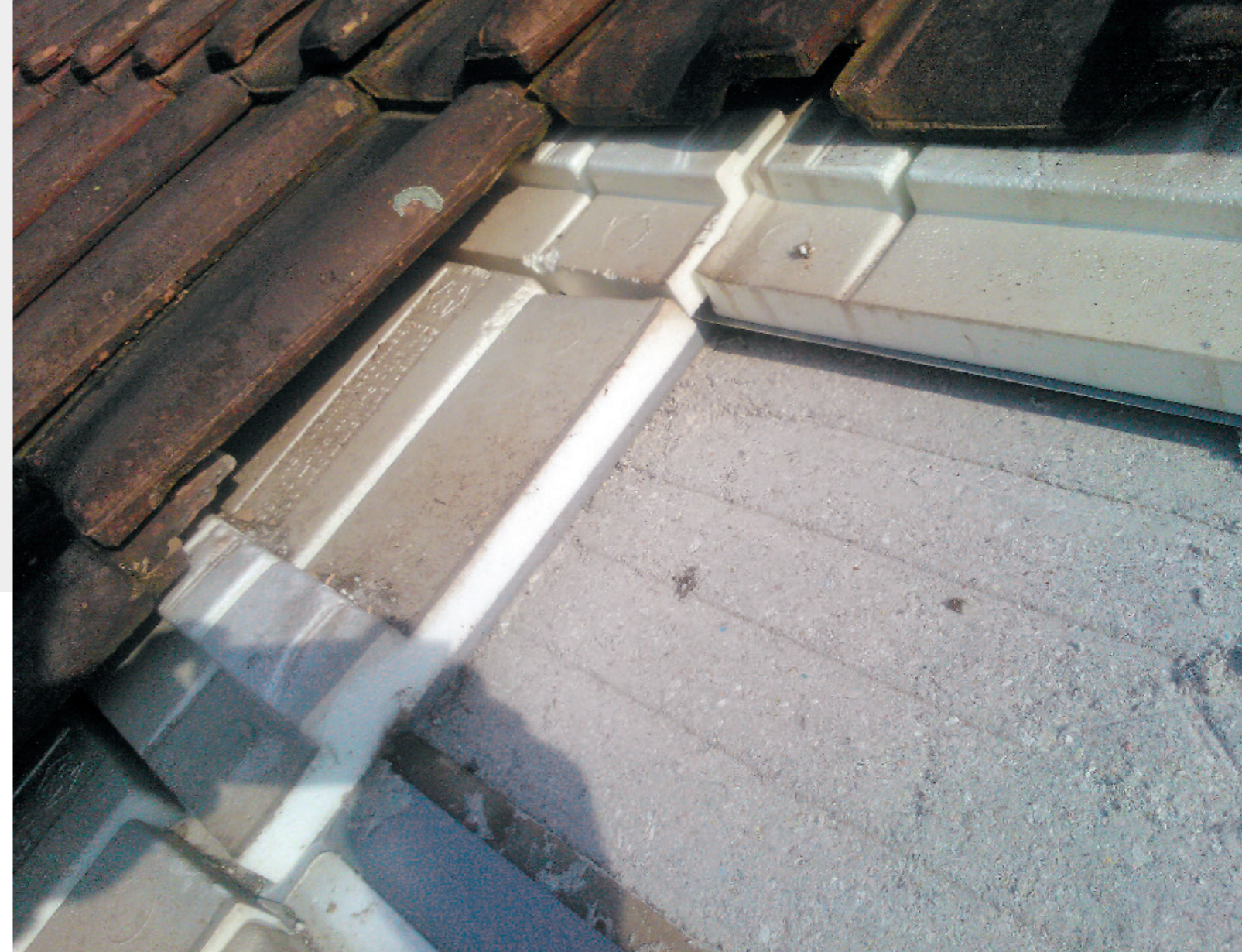
Einsicht in geöffnetes Steildach mit oberliegender bestehender Dämmung. Sehr gut sichtbar die lückenlose Dämmschicht von isofloc Zellulosedämmstoff.
