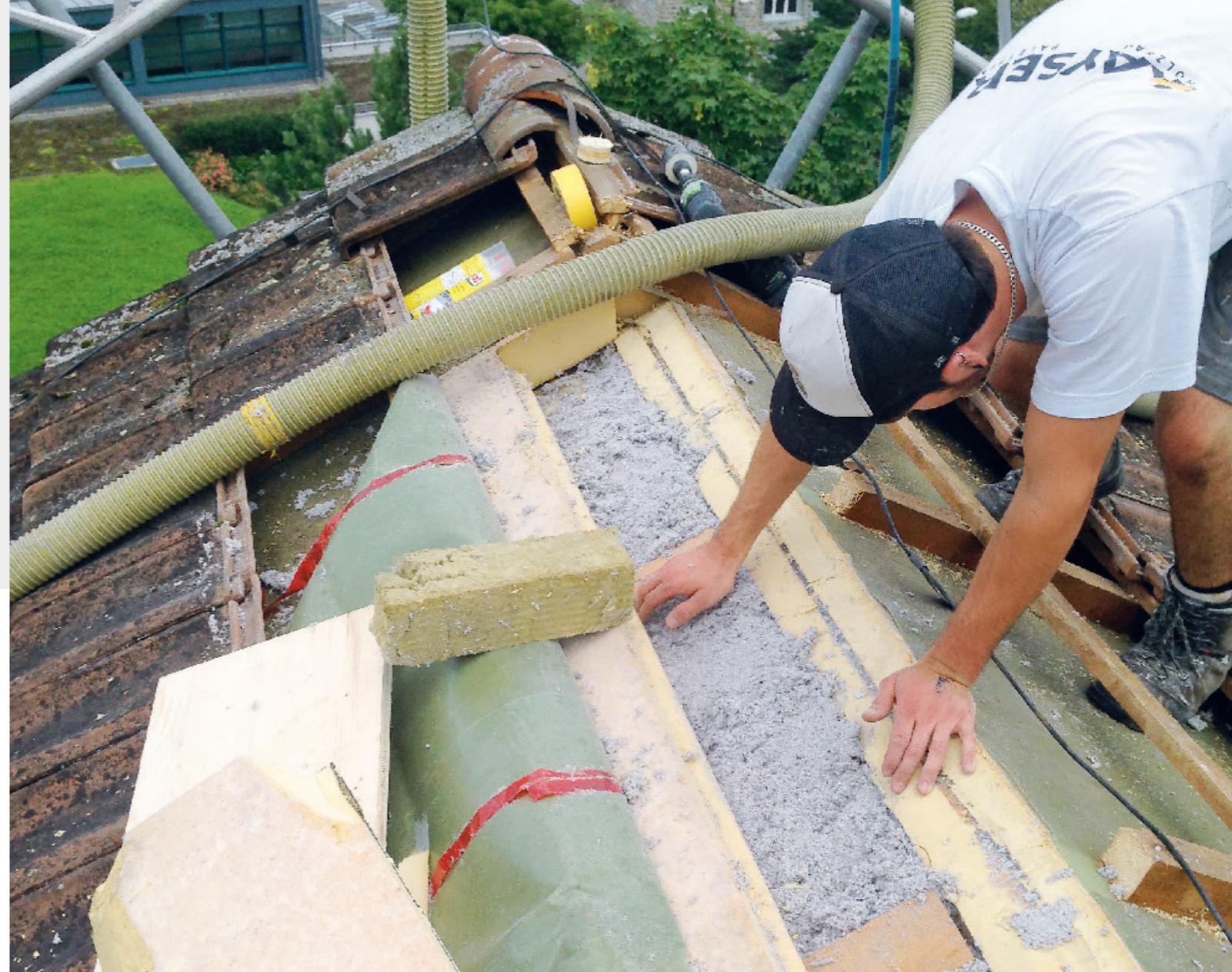
Das Schrägdach wird vom First her mit isofloc Zellulosefasern ausgeblasen.
