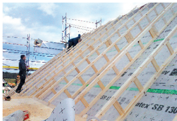
Der Aufsparrendämmhohlraum wird mit U-psi-Trägern erstellt.
